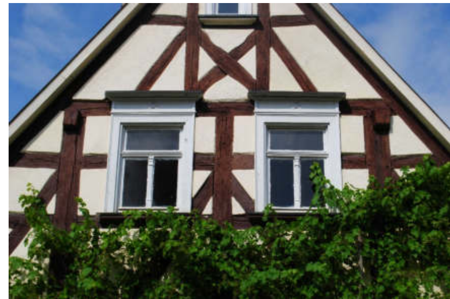
Abb. 264 – Fachwerkgiebel, Galgenfenster mit Verdachung
