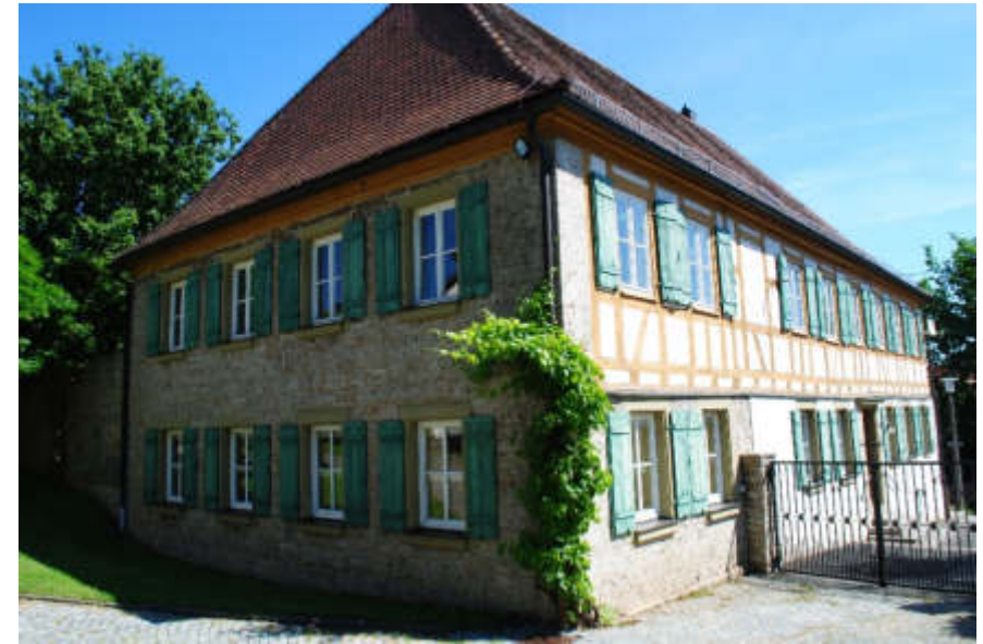
Abb. 022 – Südwestansicht mit massiver Westwand.
