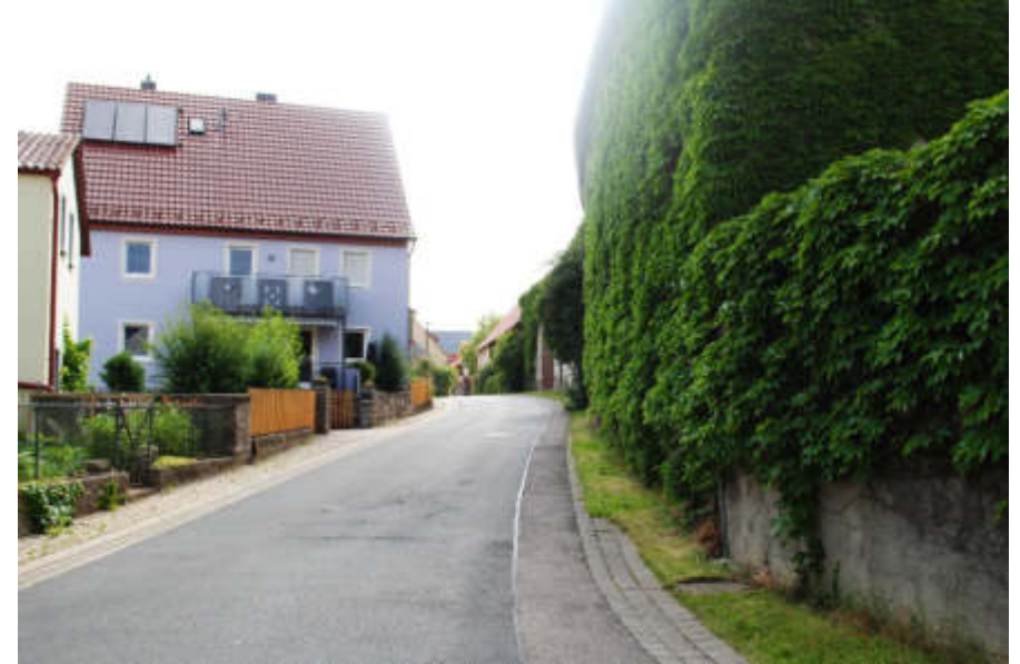
Abb. 256 – Nördliche Ringstraße gegen Osten
