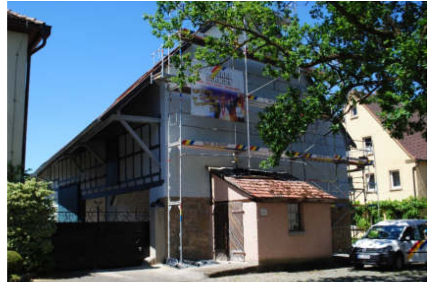
Abb. 181 – Nördliches Scheunengebäude - Ostansicht
