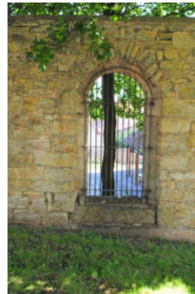
Abb. 040 – Rom. Keilsteinbogen in Ringmauer innen
