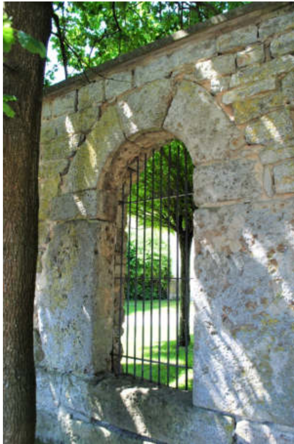
Abb. 051 – Rom. Keilsteinbogen in Ringmauer von außen
