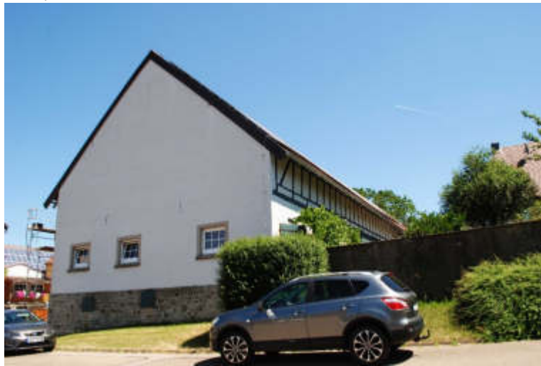
Abb. 192 – Nördliches Scheunengebäude - Westansicht
