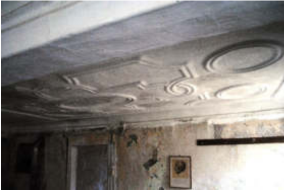
Abb. 097 – Barocke Stuckdecke im Obergeschoß
