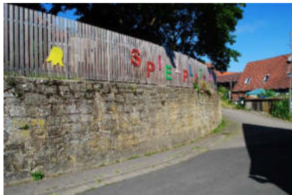
Abb. 106 – Stützmauer Gartenfläche Fl.-Nr. 75
