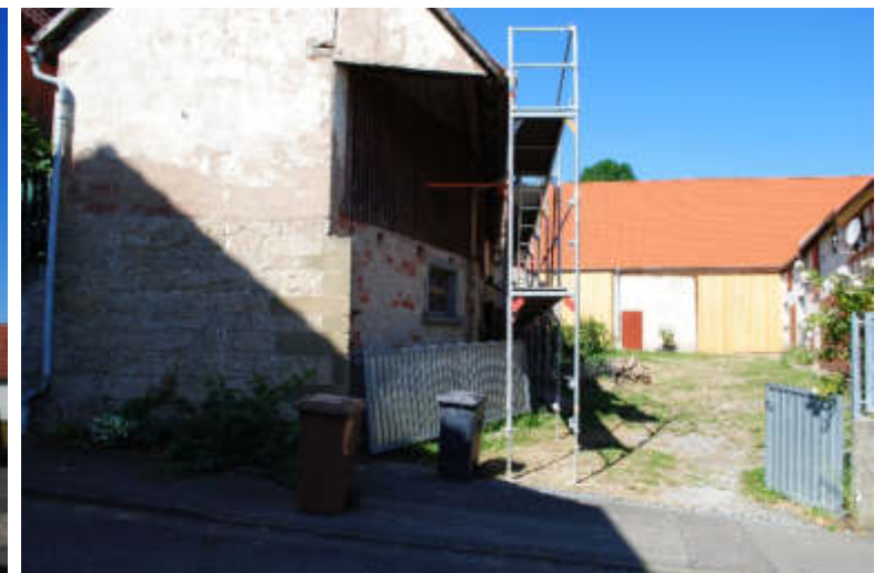
Abb. 114 – Ostansicht der Hofstelle
