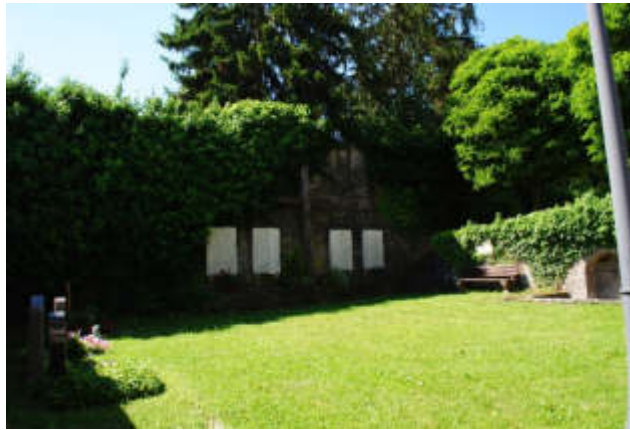
Abb. 025 – Südliche Ringmauer von innen
