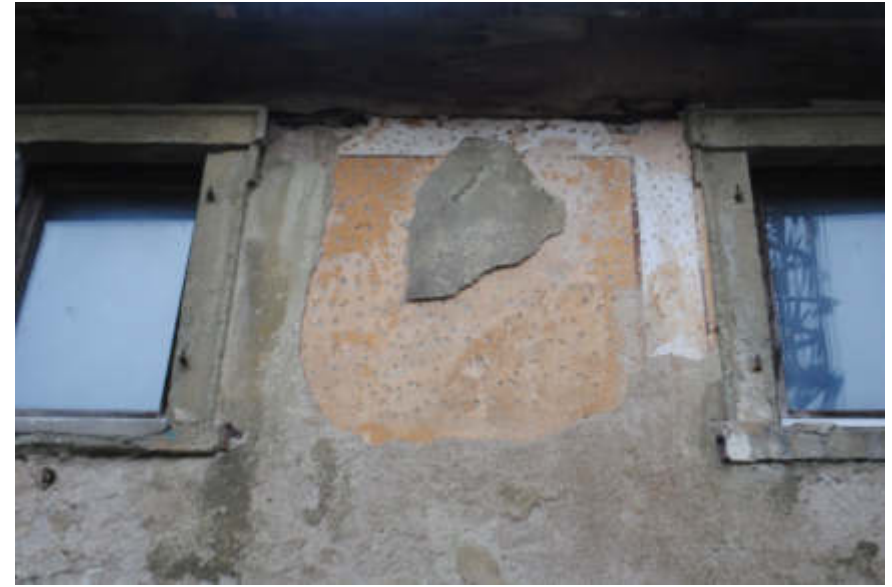
Abb. 090 – Hauptgebäude Putz- und Farbbefund
