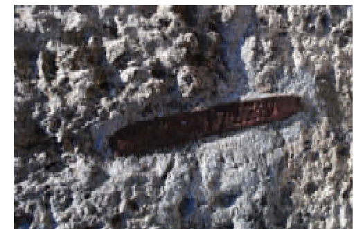
Abb. 189 – Eisenklammer bez. 1722.
