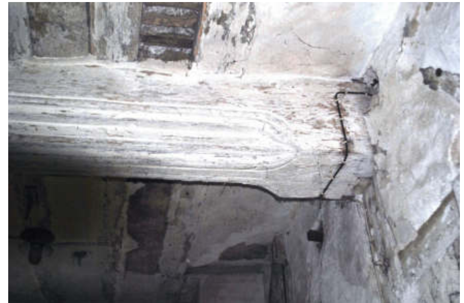
Abb. 102 – Profilierter Schiffskehlunterzug
