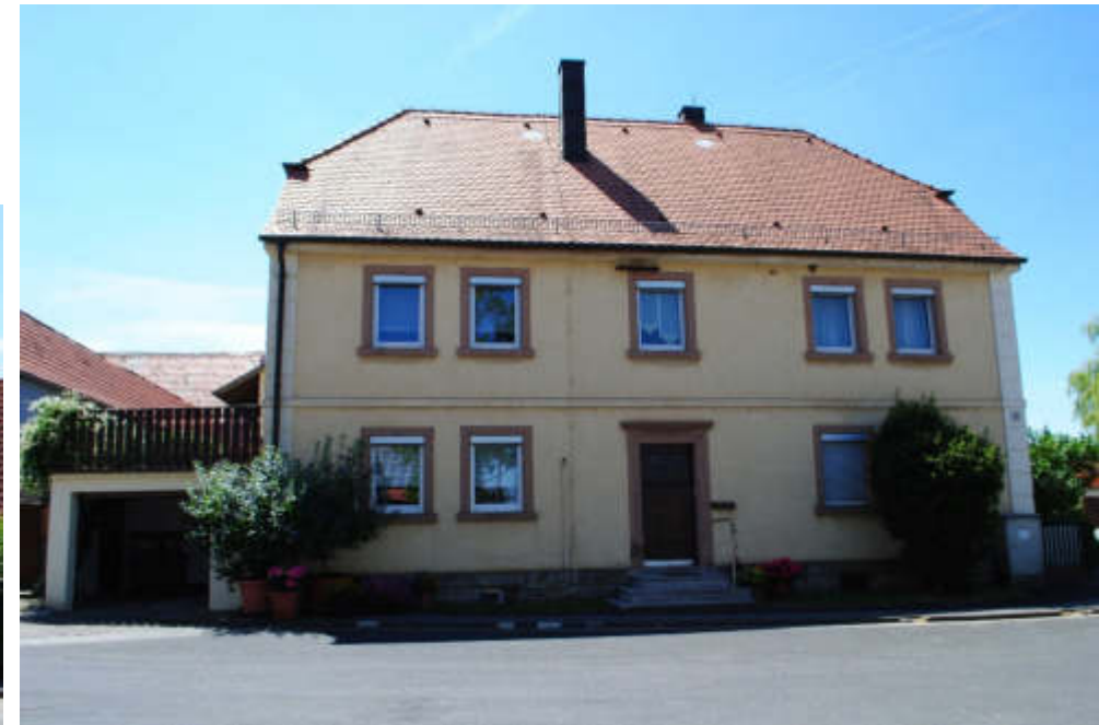
Abb. 151 – Nordfassade zur Hauptstraße
