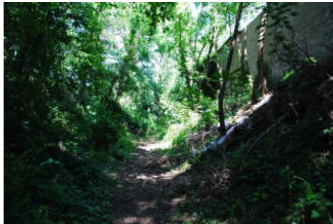
Abb. 088 – Westfront der Befestigung mit Graben und Fußweg
