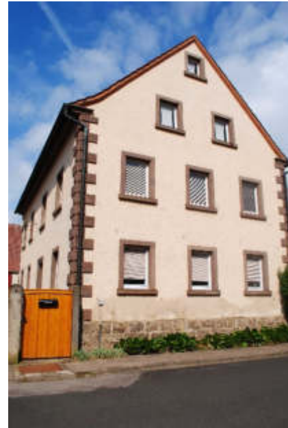
Abb. 270 – Ostfassade mit Kantenverquaderung
