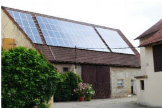
Abb. 237 – Scheune und Innenhof.
