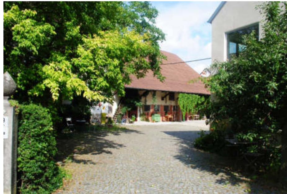
Abb. 258 – Hofzufahrt mit rückwärtiger Scheune
