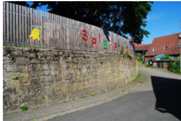
Abb. 106 – Stützmauer des ehemaligen Pfarrgartens.
