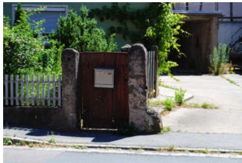
Abb. 145 – Torpfosten der Hofstelle
