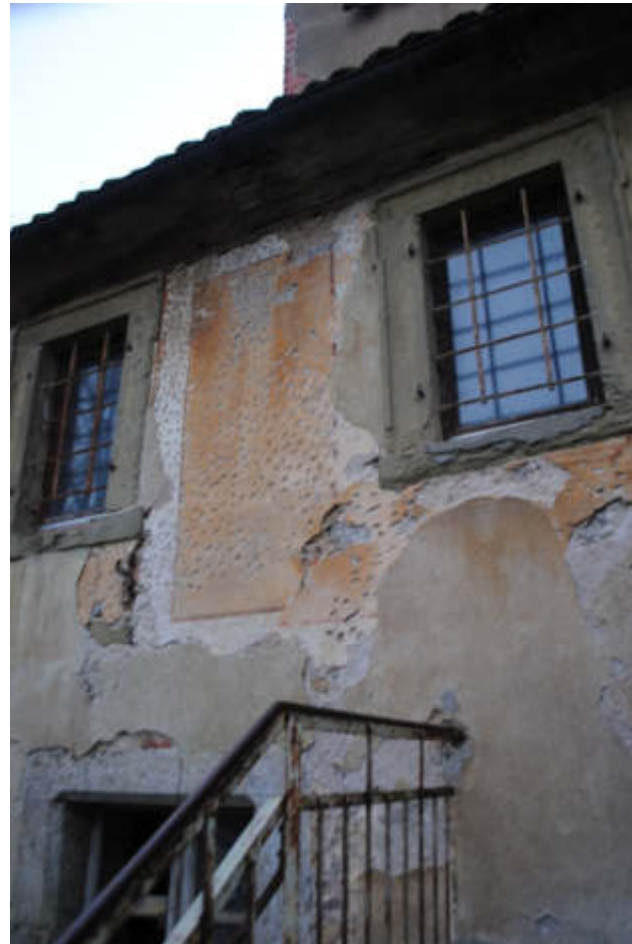
Abb. 096 – Barockisierte Fassade mit älterem Farbbefund
