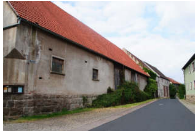
Abb. 209 – Scheune zur Ringstraße
