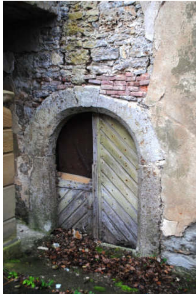
Abb. 091 – Keilstein-Rundbogen
