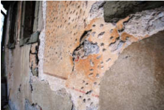
Abb. 101 – Hauptgebäude Putz- und Farbbefund
