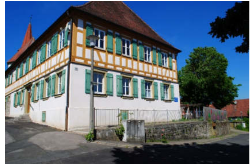
Abb. 018 – Südostansicht mit Zugang zum Kirchhof.
