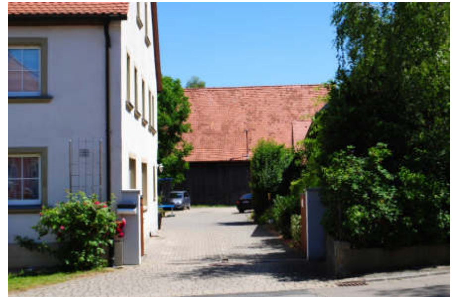
Abb. 155 – Scheune in der Rücklage
