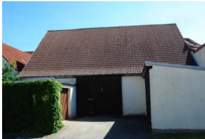
Abb. 125 – Scheune gegen Westen zur Ringstraße
