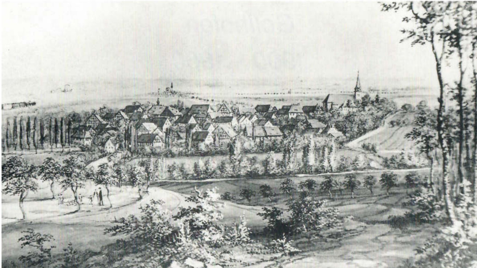
Abb. H 001 – Ortsansicht um 1890 von Nordosten
