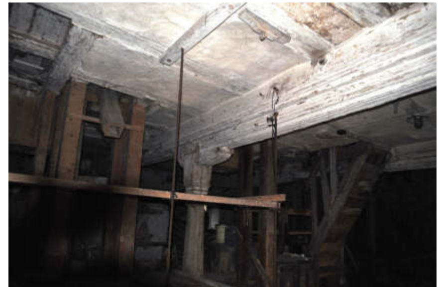
Abb. 094 – Profilierter Unterzug, Stütze mit Sattelholz
