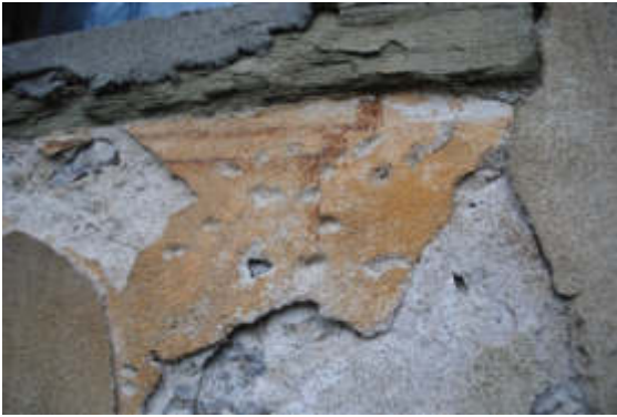
Abb. 100 – Hauptgebäude Putz- und Farbbefund
