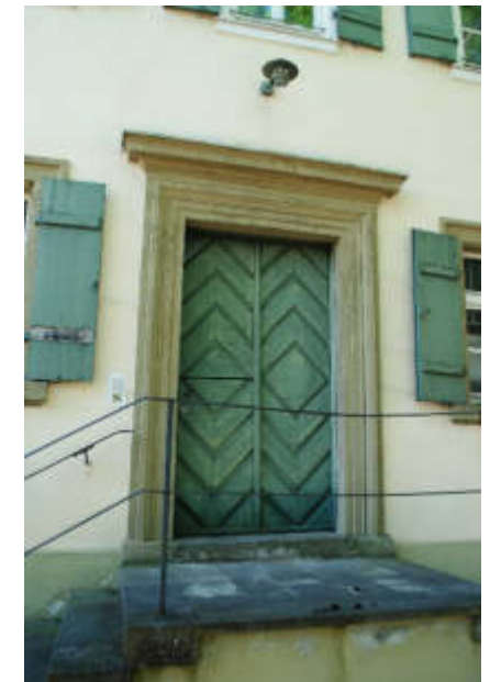
Abb. 109 – Freitreppe; Portalgewände mit Verdachung
