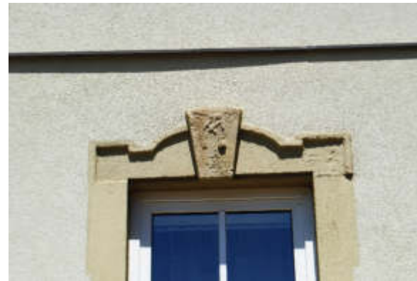
Abb. 185 – Südfassade – Hist. Fenstersturz
