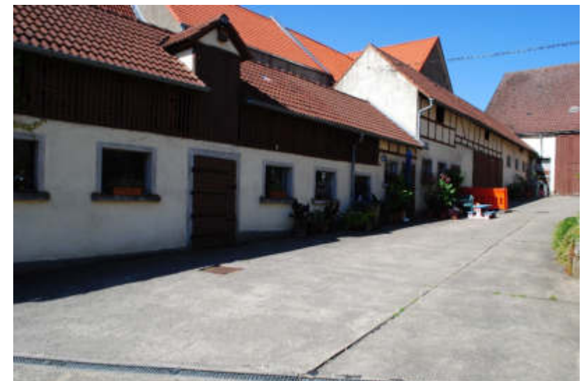
Abb. 118 – Südlicher Hofabschluss mit Nebengebäuden
